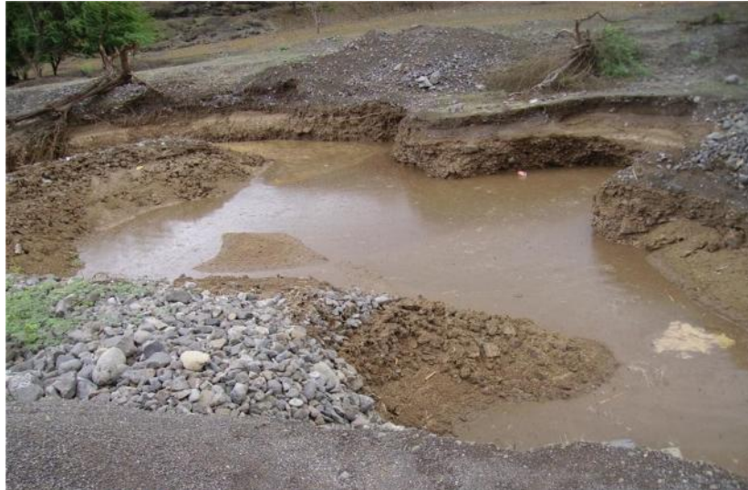
Figura. 3.9 – Cava abandonada no leito da Ribeira dos Flamengos coberta pela água da cheia. Fonte: Arquivo, Correia.
