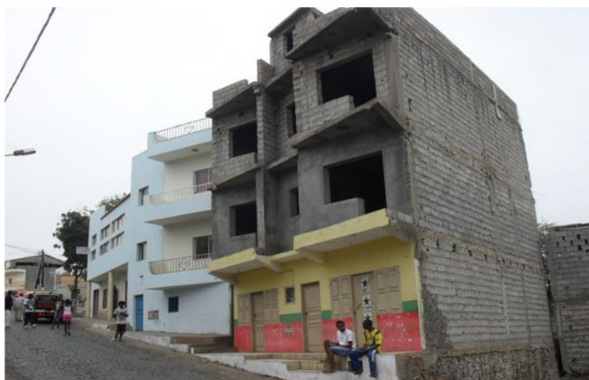
Figura. 3.3 – Edifícios modernos, feitos de blocos e cobertos com lajes de betão, no centro da Cidade de Calheta São Miguel.
