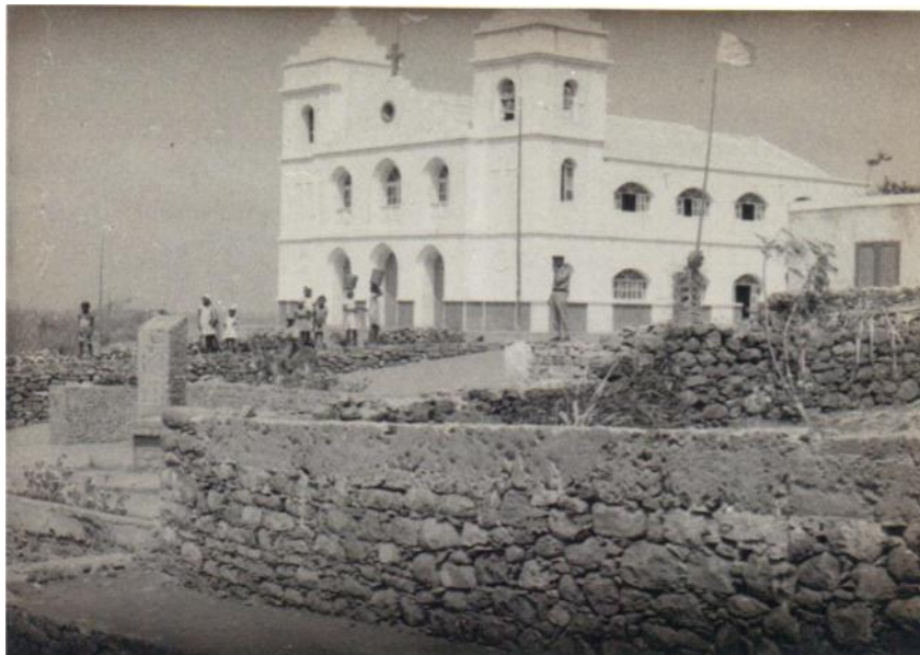
Figura. 3.5 – Fase final da construção da Igreja Matriz de Calheta São Miguel, nos anos 60. Fonte: Arquivo, Silva.
